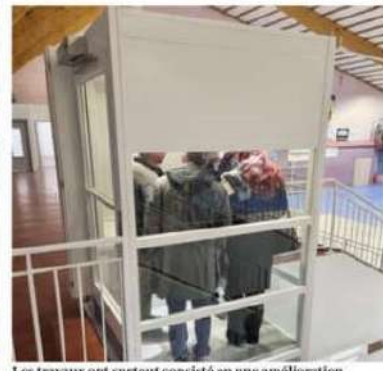
Les travaux ont surtout consisté en une amélioration de l'accessibilité du lieu, inauguré en 1981. Un ascenseur permet désormais de rejoindre les tribunes.
